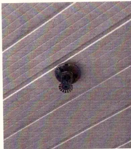
Imagem 07: Inoperância do sistema de chuveiros automáticos.
